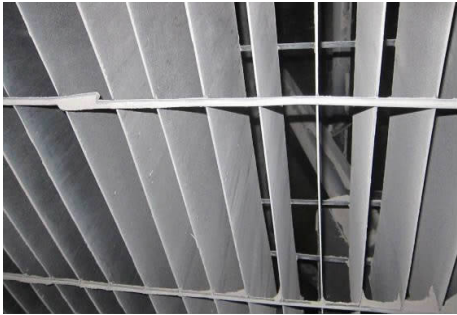
图 3 第 1 层催化剂上前部整流格栅( 灰少) Fig.3 Fore rectifier grid on the first-layer catalyst( little ash)
