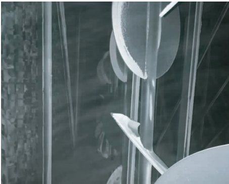
图 11 氨烟混合扰流器安装后
