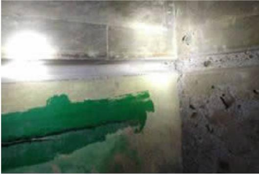
图 3 钛膨胀节使用 1 年后检测情况
