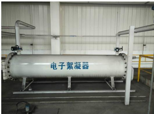
图4 电子絮凝器
