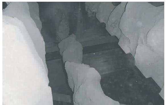
图 2 喷氨格栅积灰堵塞问题
