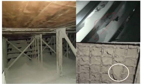
图 1 导流板和整流层积灰堵塞问题
